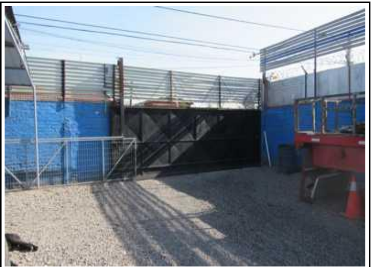
Fotografía 12: Acceso propiedad Porton
